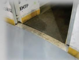
Kenarları, kenarlıklara oturacak şekilde kesilmiş ve kaynak işlemi, bütünlüğü korumak için kapalı gerçekleştirilmiştir!
